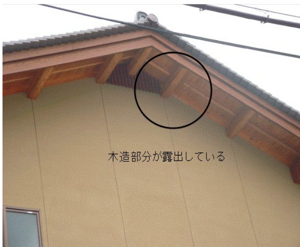
「木造（防火木造除く）」住宅の例
