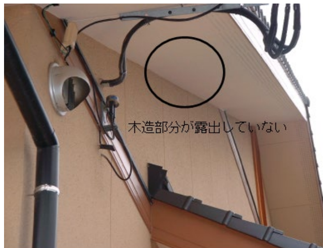
「防火木造」住宅の例
