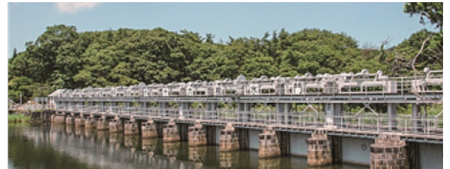
十六橋水門：疏水工事で最初に行われた、事業のシンボリックな構造物
