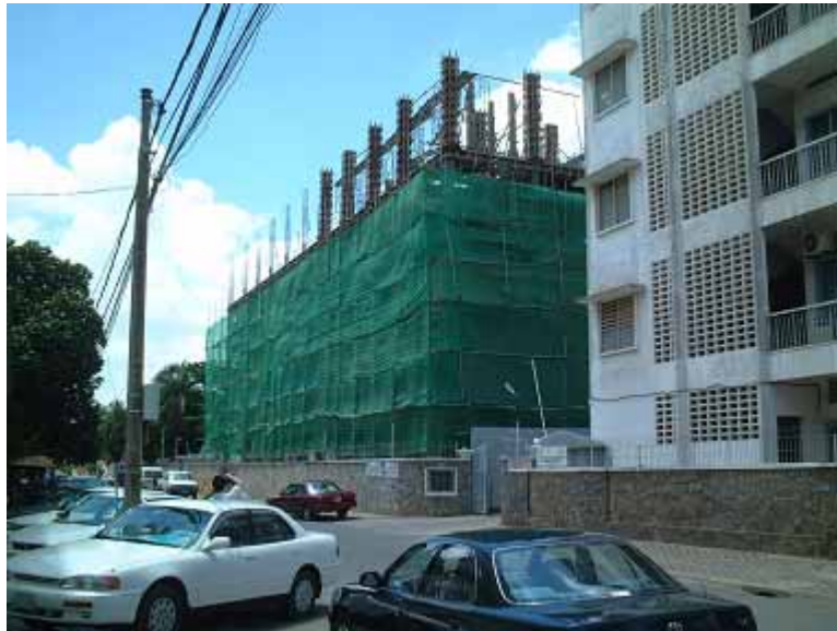
写真 1 建設が進むカンボジアの新しい統計センター（仮称）
