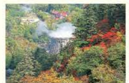
松川地熱発電所
