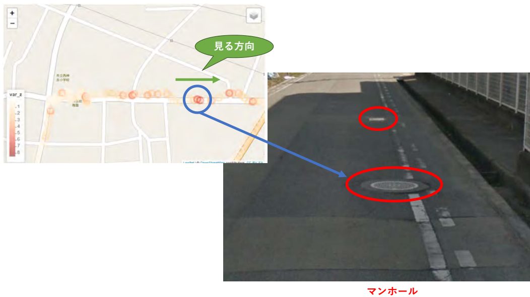
図 4.10: 2013 年 3 月時点の Google ストリートビューによる道路状況確認 4
