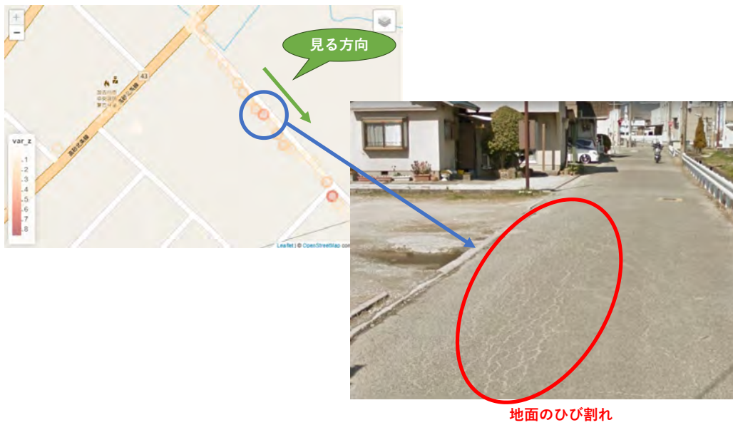
図 4.12: 2013 年 3 月時点の Google ストリートビューによる道路状況確認 5
