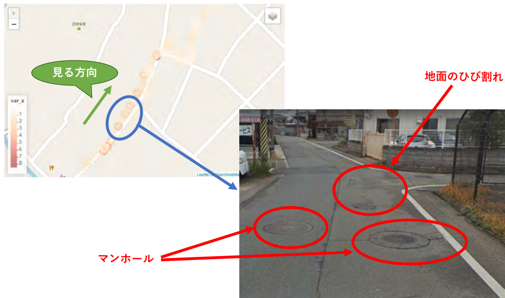
図 4.19: 2018 年 12 月時点の Google ストリートビューによる道路状況確認 9
