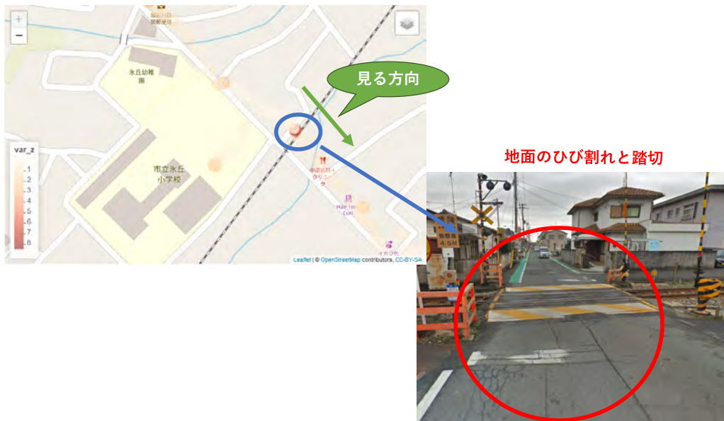
図 4.17: 2018 年 12 月時点の Google ストリートビューによる道路状況確認 8
