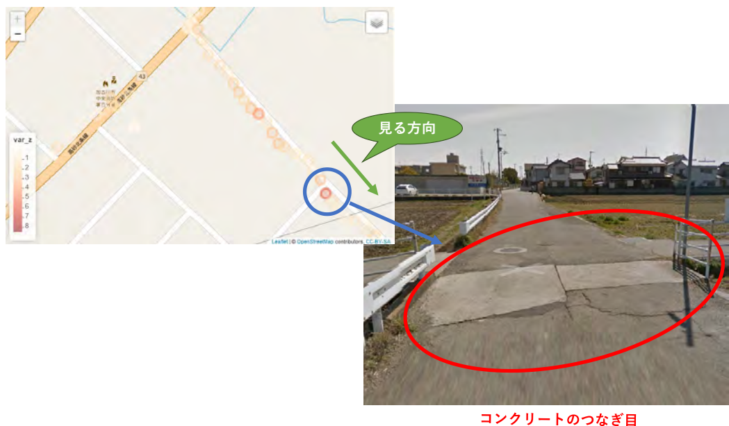
図 4.13: 2013 年 3 月時点の Google ストリートビューによる道路状況確認 6
