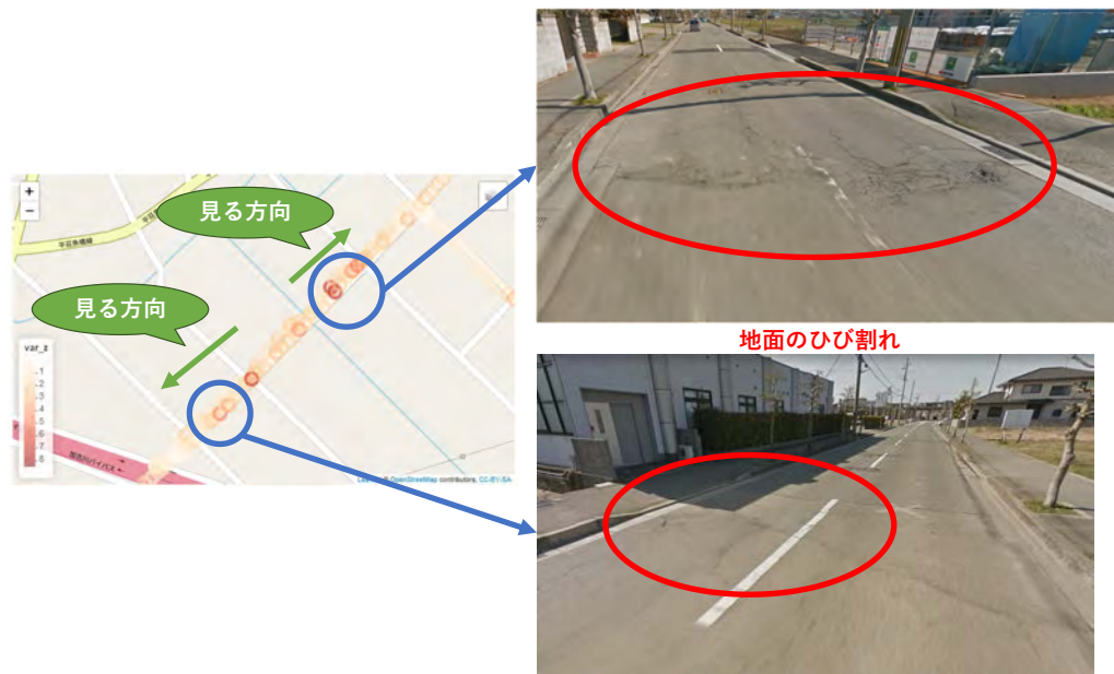
図 4.5: 2013 年 3 月時点の Google ストリートビューによる道路状況確認 1
