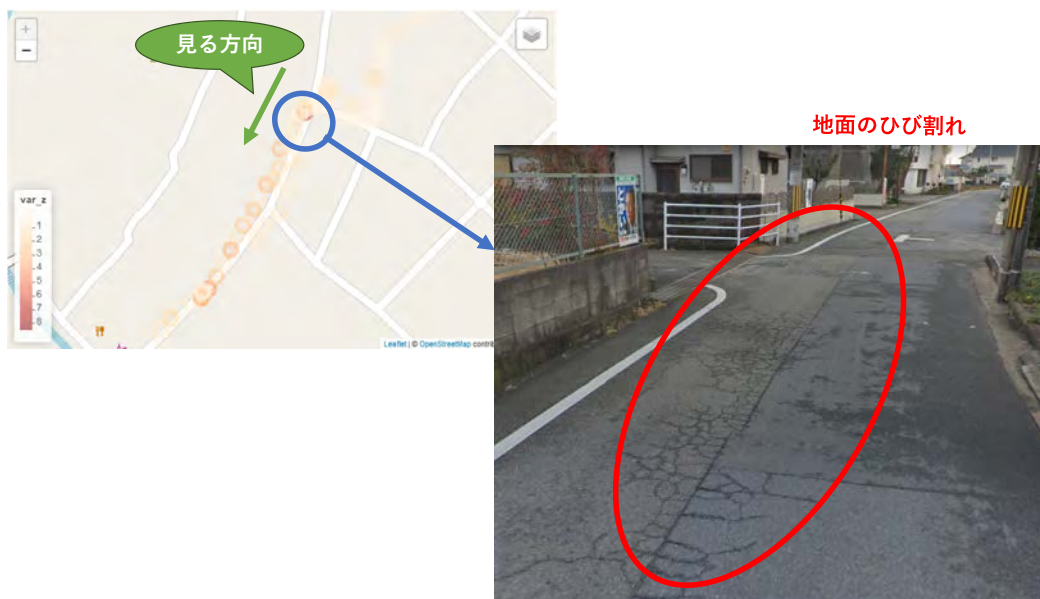
図 4.20: 2018 年 12 月時点の Google ストリートビューによる道路状況確認 10
