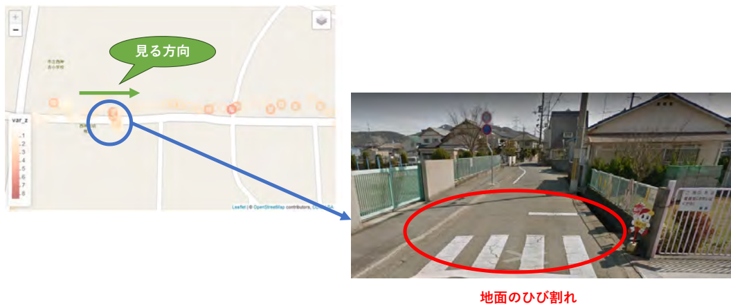
図 4.9: 2013 年 3 月時点の Google ストリートビューによる道路状況確認 3
